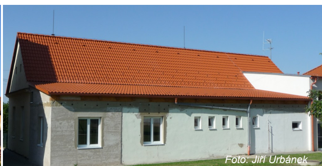
Nová střecha na staré budově školy
